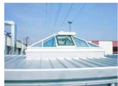
PRISMOLUX Brückenmeisterei Graz Liebenau
