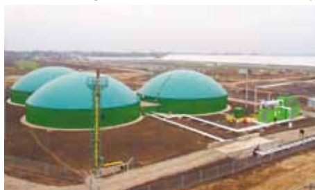
Die überschüssige, nicht vor Ort benötigte Elektrizität wird als Ökostrom in das öffentliche Netz eingespeist. Any excess electricity not needed on site is fed as ecological electricity into the public grid.
