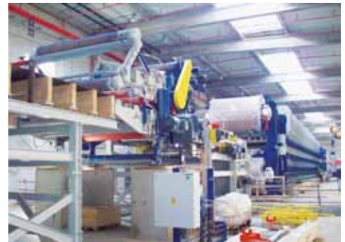
Die mechanische Montage und elektrische Installation von Sägewerksanlagen gehört weltweit zu den Kompetenzfeldern von SGS. The mechanical and electrical installation of sawmill plants is a core area of expertise for SGS worldwide.
